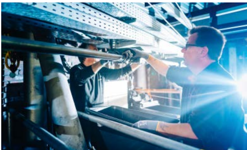
» Die 5 m langen Leitungen werden abgenommen, in einen Nebenraum geschoben und die Anschlüsse in der Wand abgedichtet.
