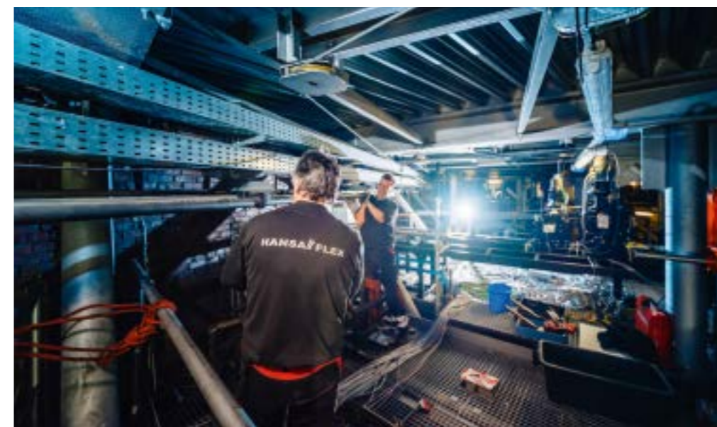
» Zur Bühnentechnik gehören 38 große Motoren für Seilwinden, die zwischen 750 kg und 1,5 t heben können und für die Bewegung der Kulissen verantwortlich sind. » The stage equipment includes 38 large motors for cable winches, which can lift between 750 kg and 1.5 tonnes and are responsible for moving the scenery.
