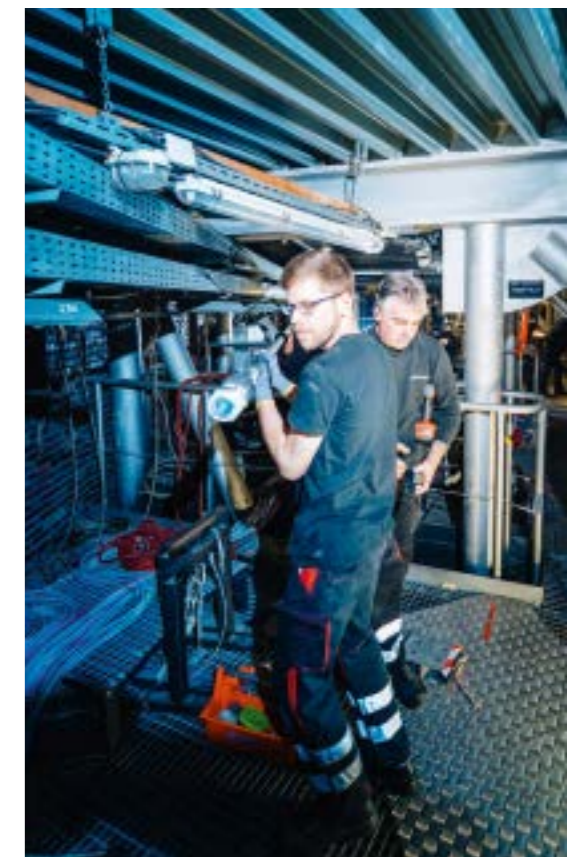
» Zur Bühnentechnik gehören 38 große Motoren für Seilwinden, die zwischen 750 kg und 1,5 t heben können und für die Bewegung der Kulissen verantwortlich sind. » The stage equipment includes 38 large motors for cable winches, which can lift between 750 kg and 1.5 tonnes and are responsible for moving the scenery.
