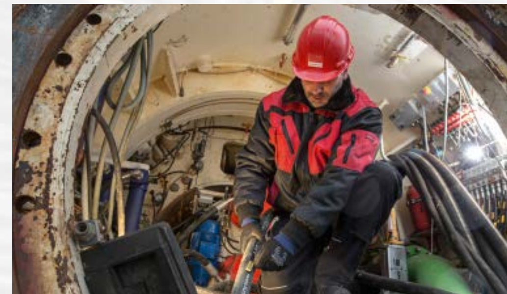
» HANSA-FLEX Servicetechniker Didier Boisdequin bei der Montage von Hydraulik-Schlauchleitungen. » HANSA-FLEX service technician Didier Boisdequin assembling hydraulic hoses.
