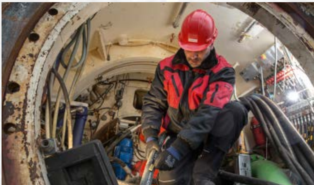
» HANSA-FLEX Servicetechniker Didier Boisdequin bei der Montage von Hydraulik-Schlauchleitungen.
