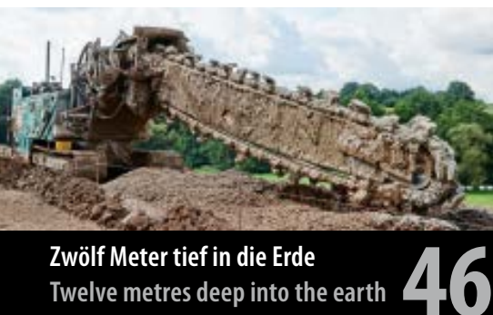
Foto/Photo: allcons Maschinenbau GmbH
